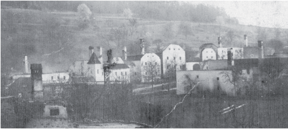
18 Häuser samt Nebengebäuden brannten nieder. Das Feuer brach im Hause Elz 8 durch Unvorsichtigkeit des 12-jährigen Sohnes aus, welcher am Dachboden mit Zündhölzern nach Hühnerestern suchte.
