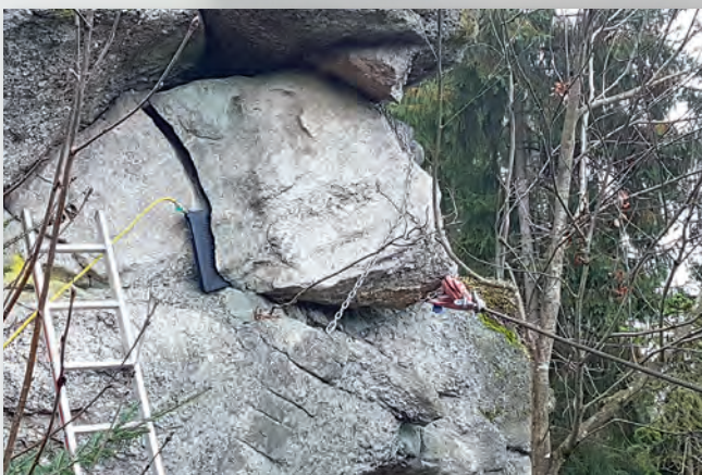
21.10.2017: Kontrollierte Felsabtragung Grieb/Hoh-Haus (25 Tonnen Fels drohten auf Wanderweg zu stürzen) Einsatzleiter: BI Waldmann Martin Einsatzstärke: 10 Mann
