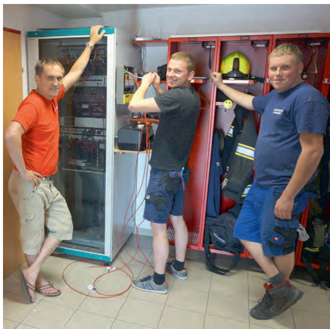
V.l.n.r.: Die Kameraden Hauschmied Gerhard, Affenzeller Josef und Freudenthaler Jakob bei der Montage der Brandmeldeanlage.
